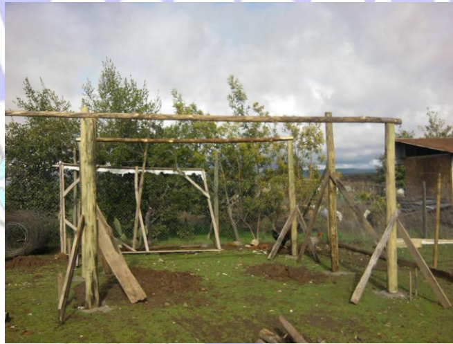
Jaime González Palominos. Proyecto PDI Construcción de Bodega de 35 m 2
